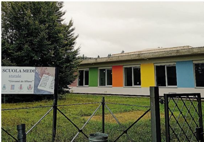
Terminati gli interventi alla scuola media
