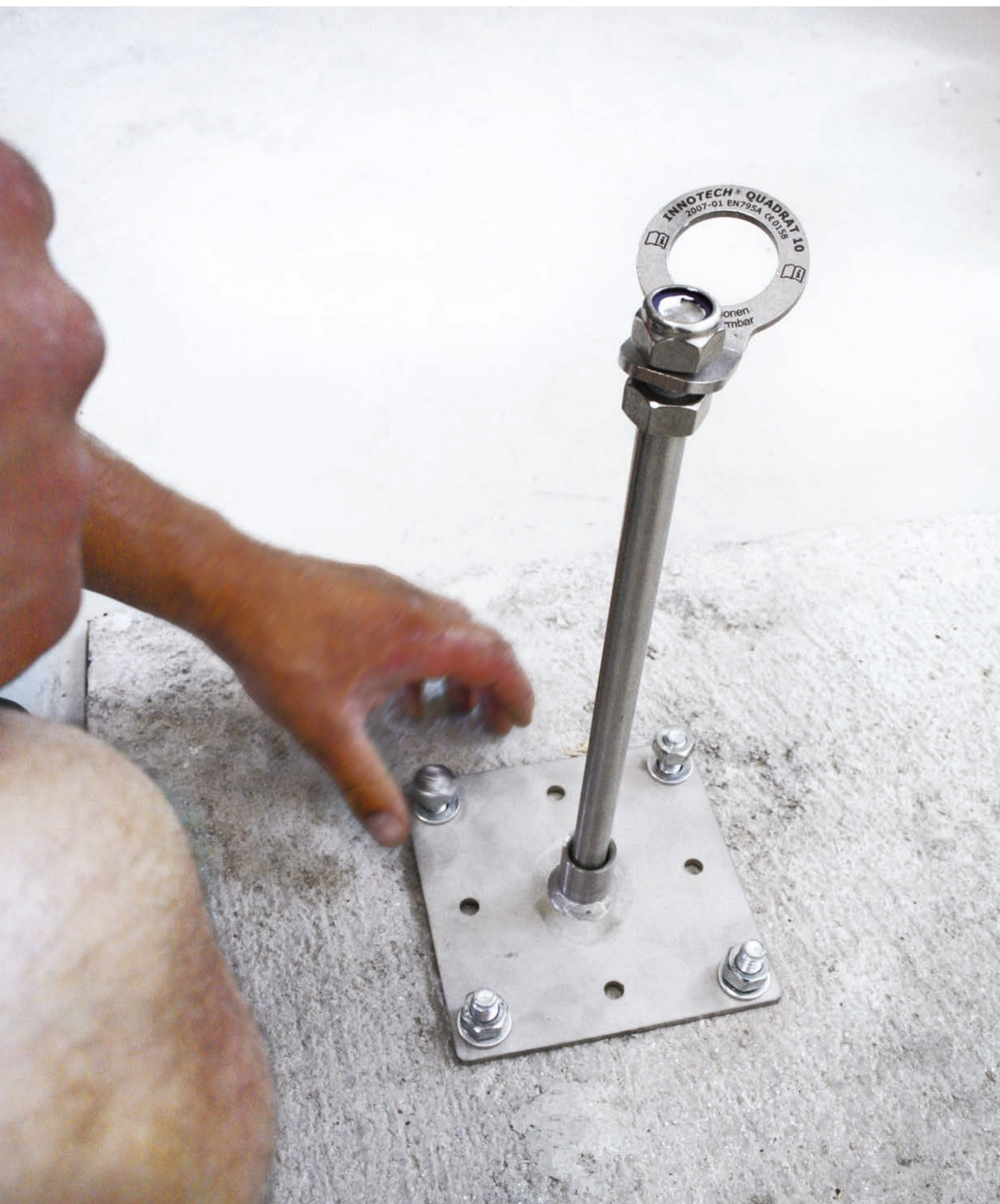
(immagine presa durante il montaggio) /// Abbildung während der Montage!
